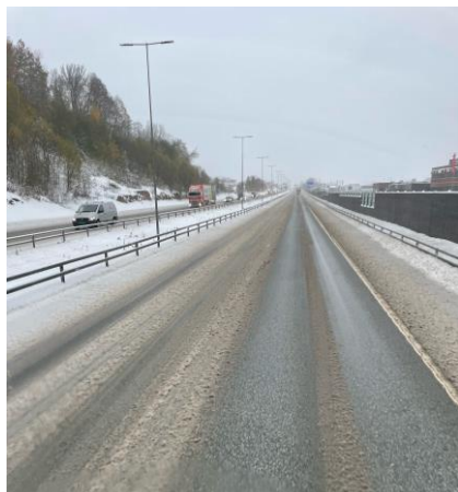
Ved Drammen var det dårlig
