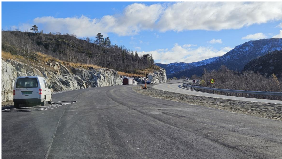
Den nye kolonneopptillingsplassen ved Vågslid var i ferd med å bli fullført i oktober
